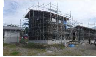
建設中のファサードラタン外壁がおしゃれでエコなアトリエ
